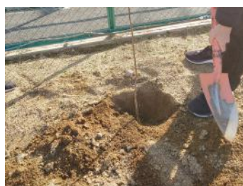
掘削作業開始!
